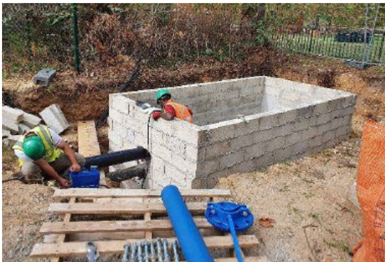
Intervention SUEZ (ouvrage d'adduction EP)
