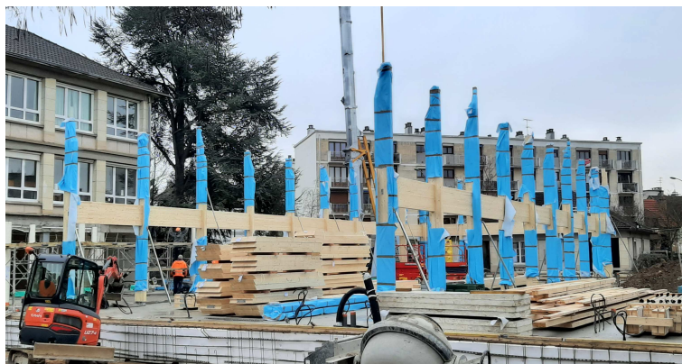
Pose charpente bois - 19 janvier 2023c
