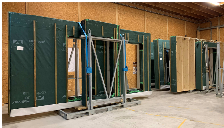
Fabrication des murs à ossature bois - décembre 2022
