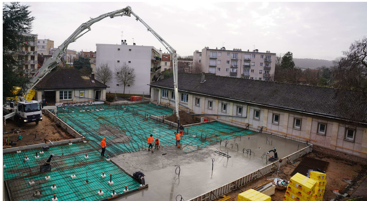
Coulage du plancher béton - 22 décembre 2022
